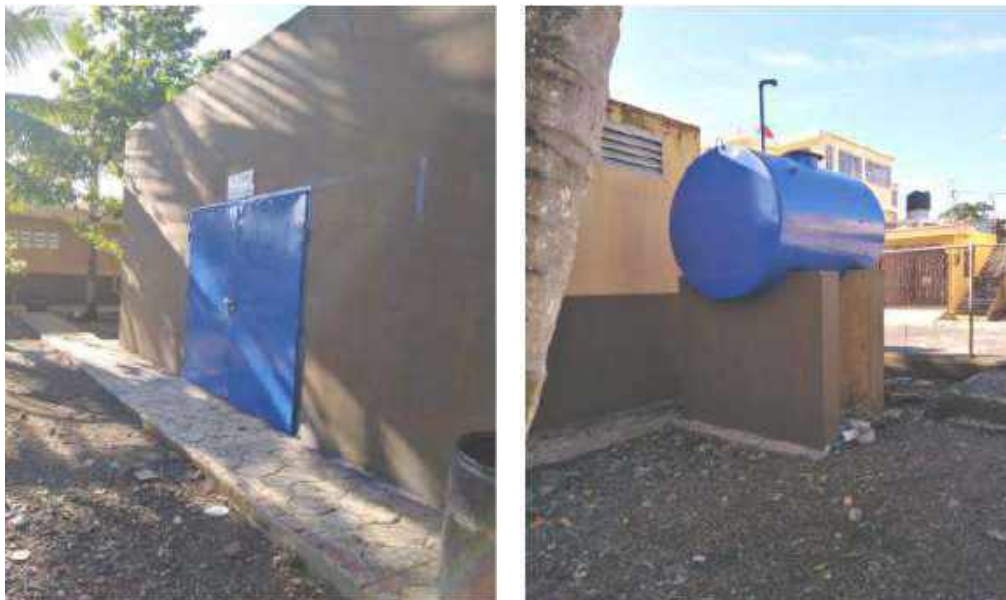
Acondicionamiento y pintura del área de la planta eléctrica.
