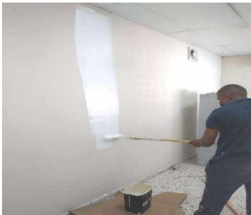
Acondicionamiento y pintura del patio y la escuela.
